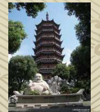
(蘇州) 北寺塔報恩寺
